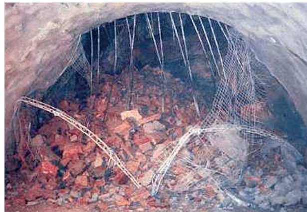
Arriba y a la derecha, fig. 3. Colapso del túnel de Línea Meteor del Metro de París, 15 Feb. 2003. Abajo a la derecha, fig. 4. Colapso del túnel del Herzogberg, Graz, 11 Ago. 2001.
