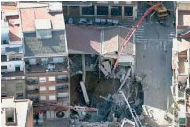
Fig. 1. Colapso del túnel de Línea 5 del Metro de Barcelona (Nuevo Método Austriaco).
