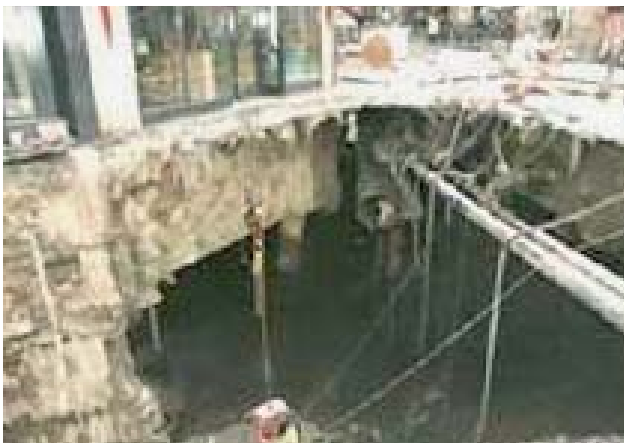
Fig. 2. Colapso del túnel de Línea M2 del Metro de Lausana. Obsérvese el colapso del frente y la entrada del material en el túnel. Compárese con el esquema de la figura 14.
